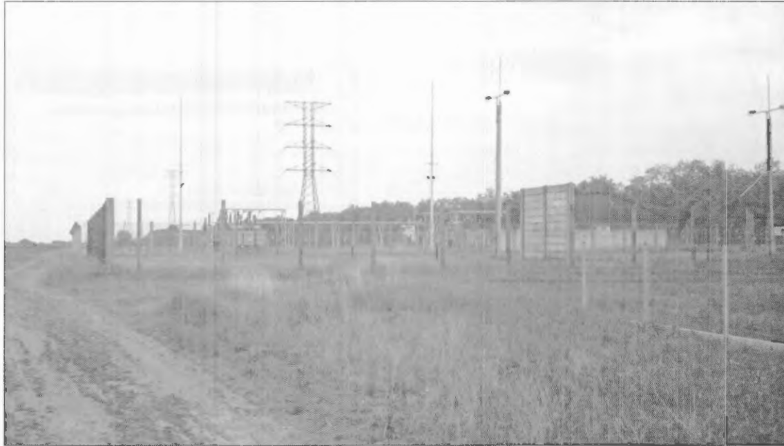
11. ábra: Transzformátor állomás a szomszédos területen
