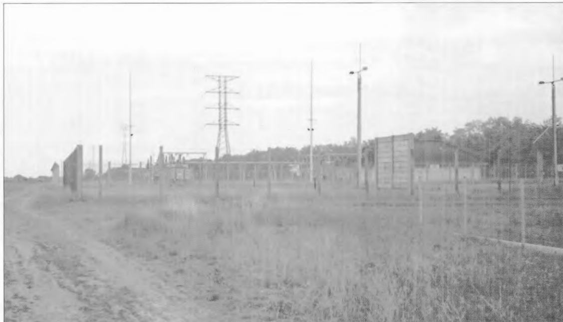
11. ábra: Transzformátor állomás a szomszédos területen
