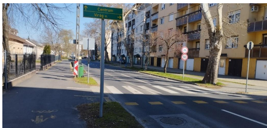
57. ábra: Akadálymentes, taktilis burkolati jelekkel ellátott gyalogátkelő és kerékpáros átvezetés (fotó: Gertheis Antal)
