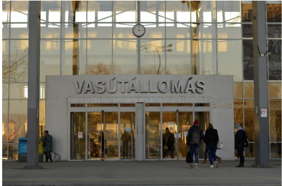
9. kép: Nyíregyháza vasútállomás bejárata a homlokzat felől
